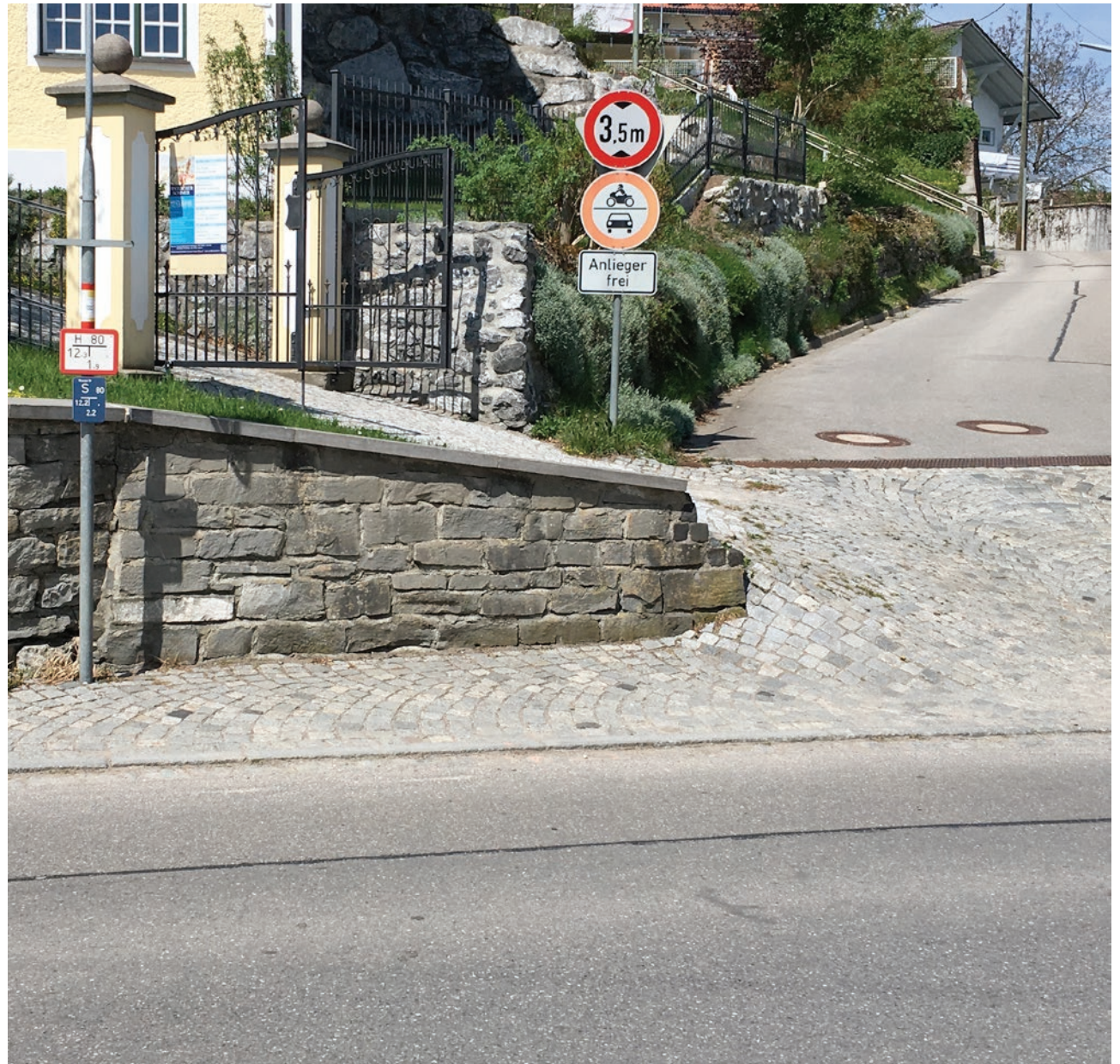
Blick 04 / Höhengsprung innerhalb des Fußweg – Ecke Hauptstraße / Kirchberg
