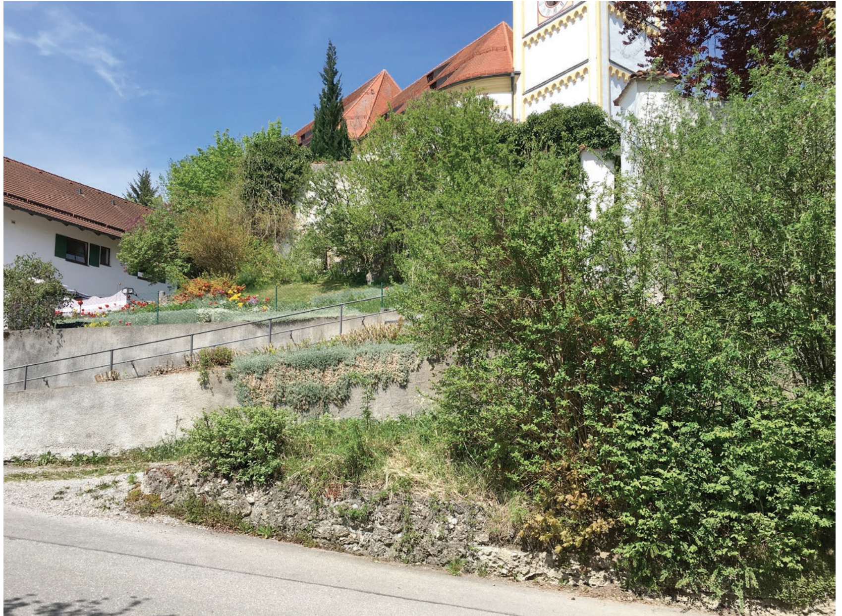
Blick 27 / Zugang St Michael über Bergstraße
