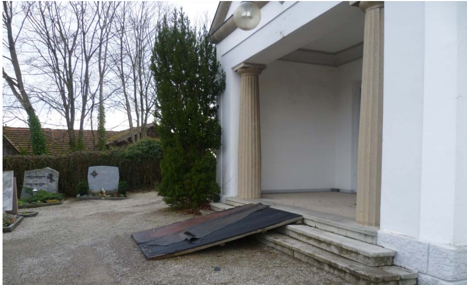
Abbildung 3: Bestand Zugang Aussegnungshalle
