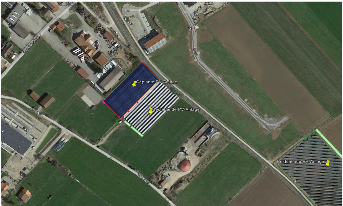
Bild 2.1.2: Luftbild der PV-Anlage (Quelle: Google Earth / SolPEG)
